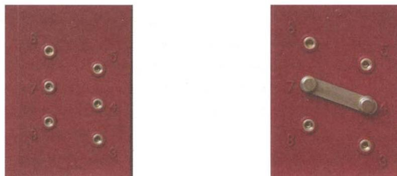
شکل ۶ - خروجیهای تنظیم ولتاژ در بین فشار قوی
