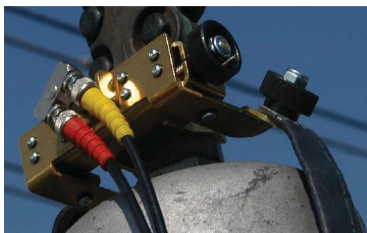
شکل (۲). نحوه اتصال کابلهای اندازه گیری به پوشینگها
